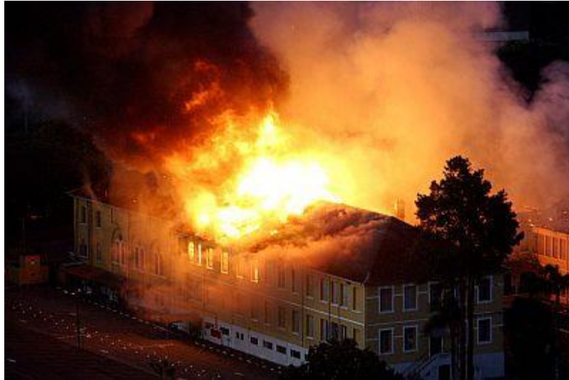
Figura 6 - Incêndio em Universidade em Curitiba - PR
