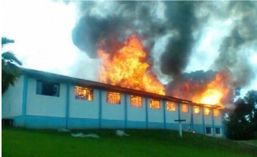
Figura 5 - Incêndio em escola em São José do Cerrito
