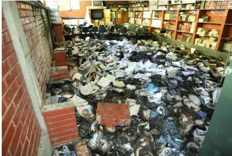
Figura 4 - Incêndio em escola em Belo Horizonte
